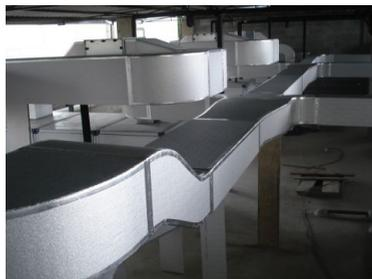
Figura 27. Exemplos de rede de dutos utilizados para climatização e renovação de ar
