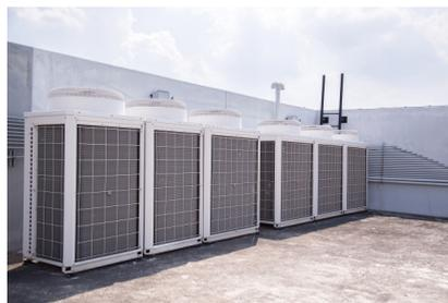
Figura 14. Equipamento do tipo Splitão
