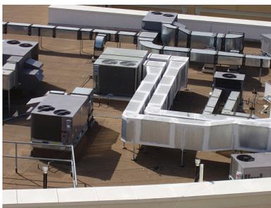
**Figura 13. Equipamento do tipo Rooftop**
